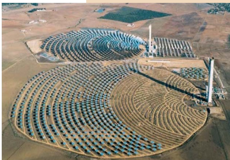
Les centrales solaires à concentration, ici la centrale PS20 en Espagne.
