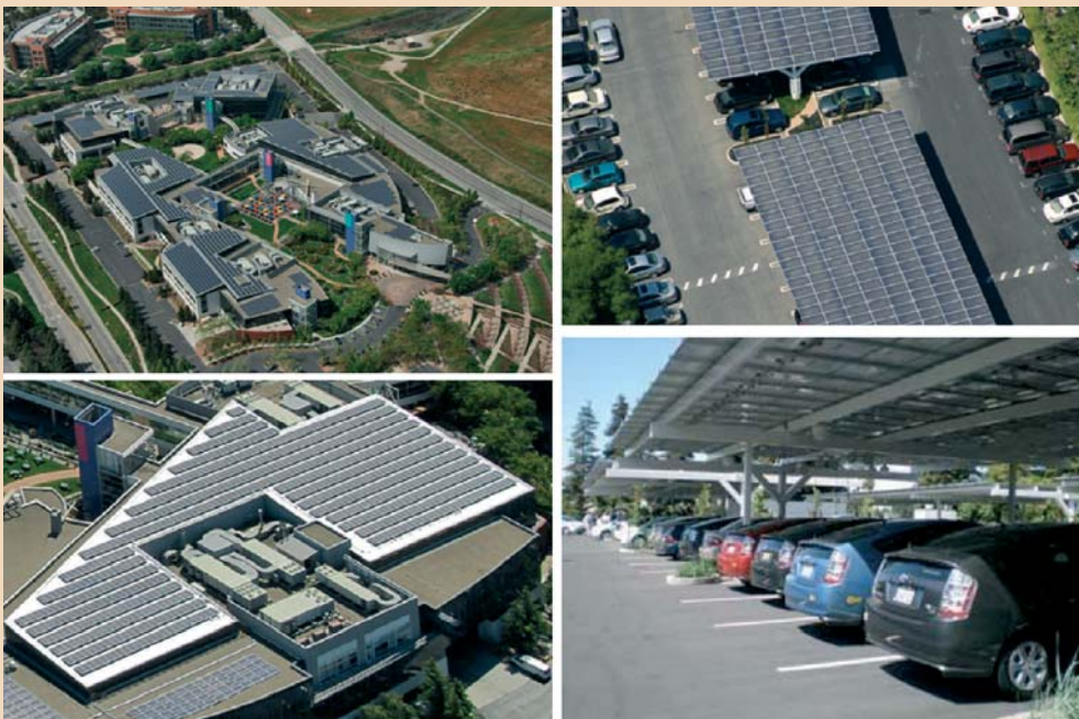
Le campus Google à Mountain View en Californie avec son installation photovoltaïque de 1,6 MW et sa flotte de véhicules hybrides rechargeables.
