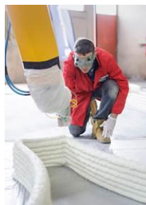
© YHNOVA/TICA/Nantes Métropole Habitat/ ↑ Construction d'un logement social à l'aide d'une imprimante 3D - Projet BatiPrint3D batiprint3d.fr ← © F. Toms/Université de Nantes
